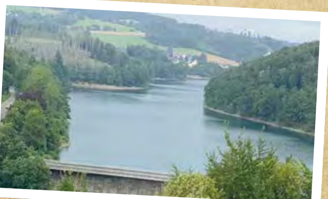
Ein Blick auf die Talsperre.
